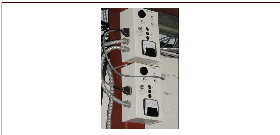
شکل ۷۷- قفل داخلی در اتاق پرتونگاری صنعتی
