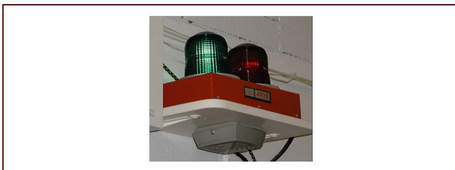
شکل ۷۶- به کارگیری چراغ ایمنی در خارج از اتاق پرتونگاری صنعتی
