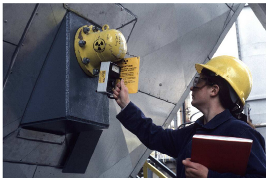
شکل ۶۴- مونیتورینگ پرتو نشتی در سطح کانتینر سطح سنج پرتوی
