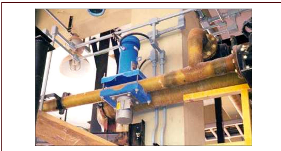
شکل ۲۱- اندازه گیری پیوسته چگالی در صنایع
