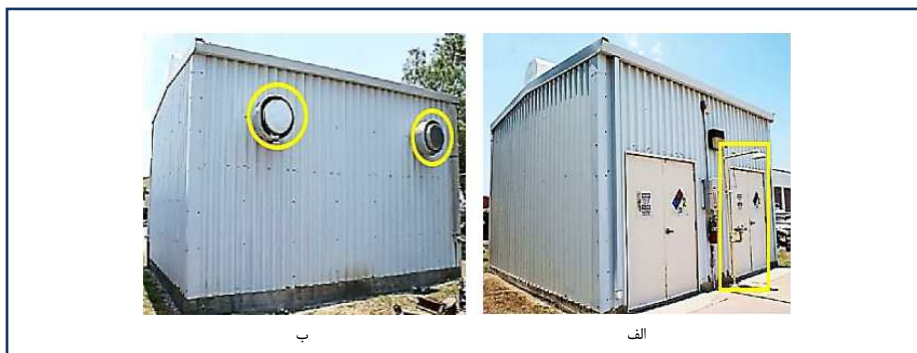
شکل ۱-۱: دوش حمام (الف) و سیستم تهویه (ب) در جایگاه ذخیره سازی موقت
